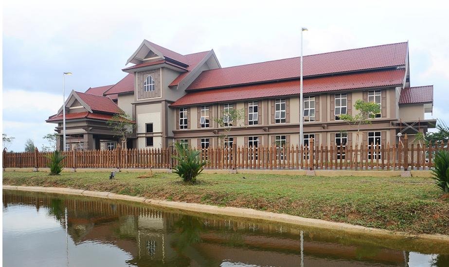
Bangunan Pusat Mahasiswa UMK Kampus Bachok.
