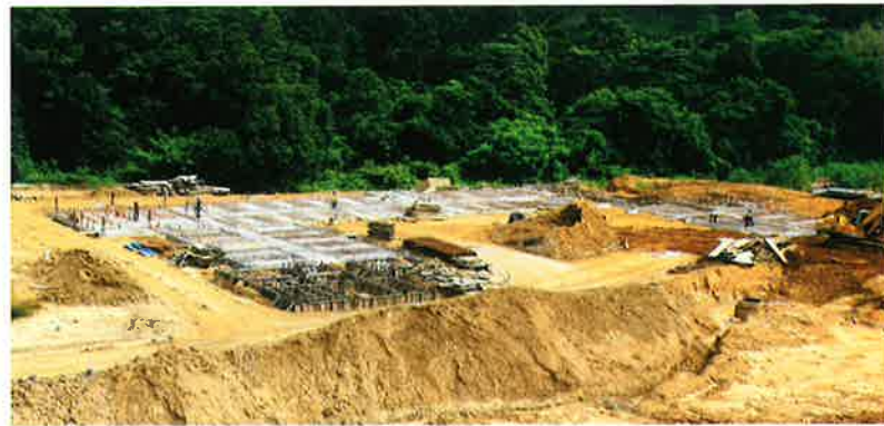
b) Kerja-kerja membina rasuk dan lantai aras bawah Blok Asrama Perempuan
