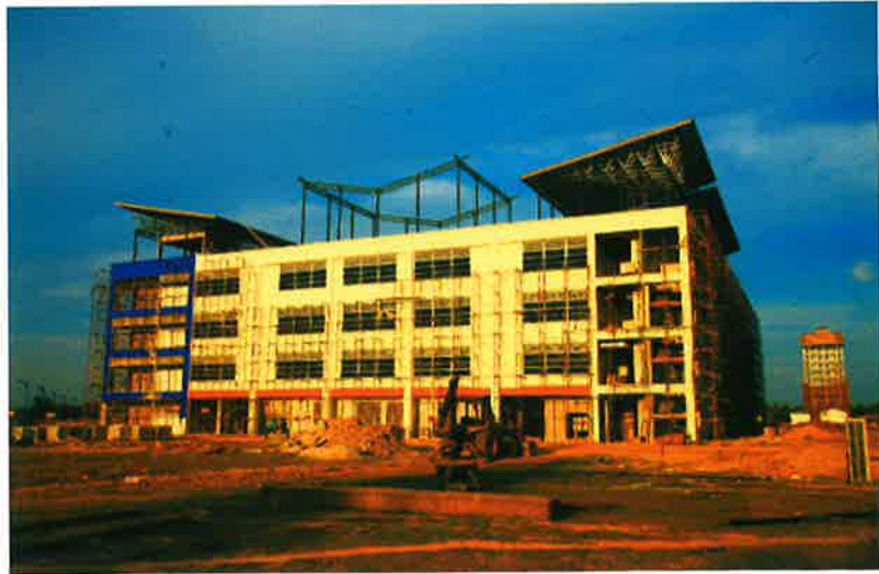
b) Blok Bangunan Akademik & Pembelajaran sedang dalam proses kerja-kerja pemasangan bumbung
