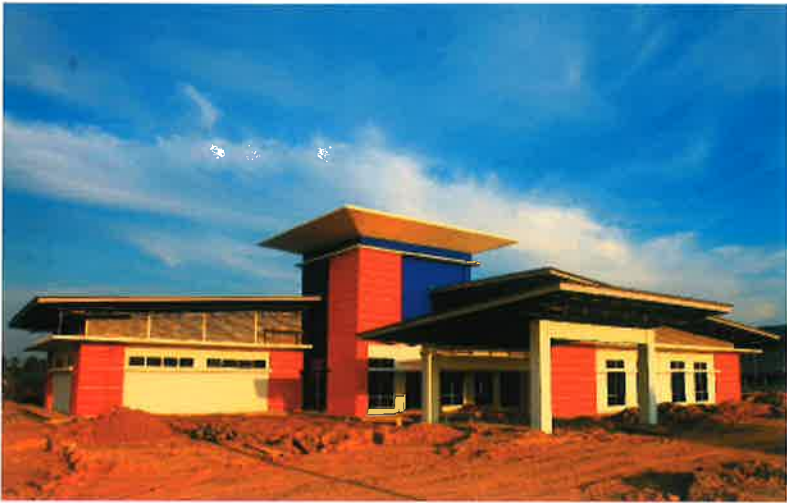
c) Bangunan Pejabat Pembangunan, Infra & Perkhidmatan sedang dalam proses penyiapan pembinaan
