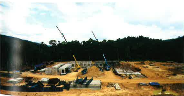
a) Kerja-kerja memasang dan konkrit 'Shear Wall' aras bawah Blok Asrama Lelaki
