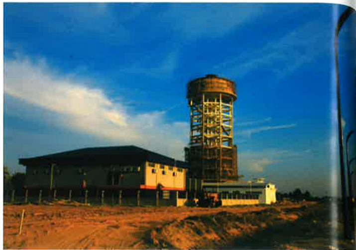
d) Menara tangki air sedang dalam proses pembinaan dengan ketinggian 40 meter
