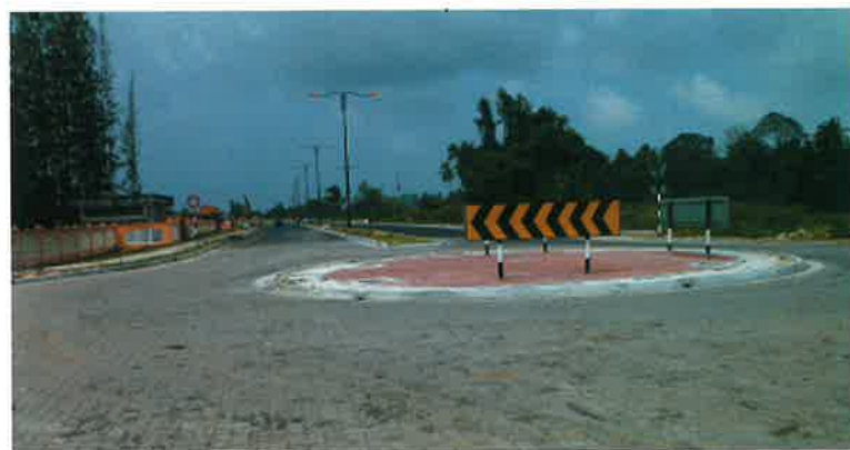
i) Bulatan jalan di hadapan Pintu Masuk ke UMK Kampus Bachok
